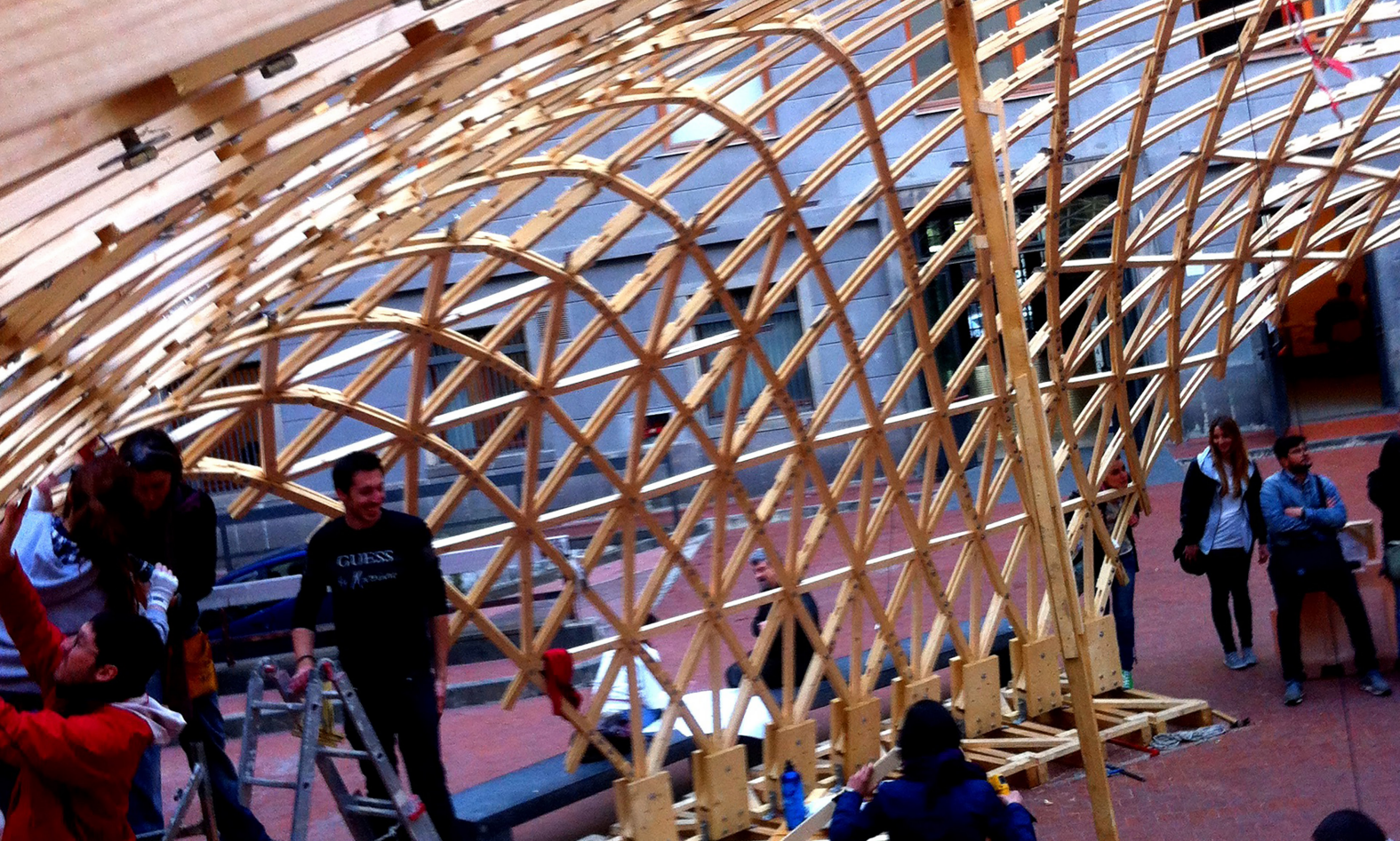
Fig. 1 Toledo Gridshell in costruzione (Foto Daniele Lancia)
