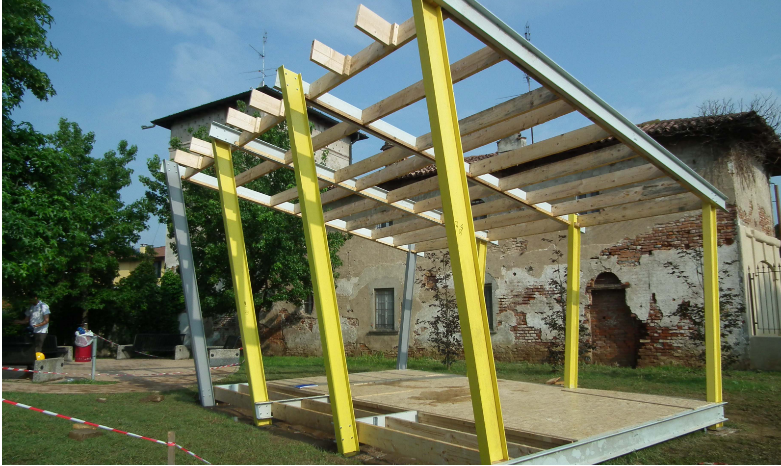
Fig. 2 Modulo Stone 2 realizzato ad Abbiategrasso nel 2014 dagli studenti del Laboratorio di Costruzione 1 della Scuola di Architettura del Politecnico di Milano – prof. A. Rogora e prof. M. Fianchini. Il modulo è realizzando utilizzando un sistema Segal modificato che utilizza elementi strutturali di recupero in fibra di vetro accoppiati ad elementi in legno.
