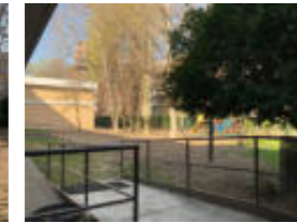
3 - Rampa di accesso al cortile
